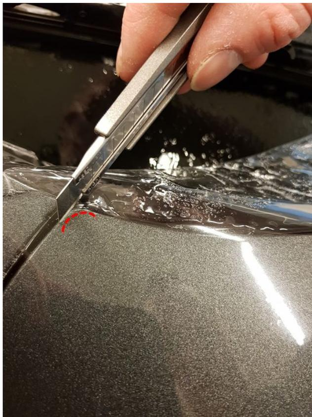
Para facilitar su cortado, asegúrese de utilizar cuchillos muy afilados: los cuchillos poco afilados pueden generar bordes de corte imprecisos. Al aplicar el Avery Dennison Pure Defense PU y PVC, se recomienda utilizar cuchillas de acero inoxidable con su herramienta de corte. El uso de cuchillas de acero inoxidable es necesario para retrasar la oxidación y el deterioro de las cuchillas, debido al contacto con el agua.
