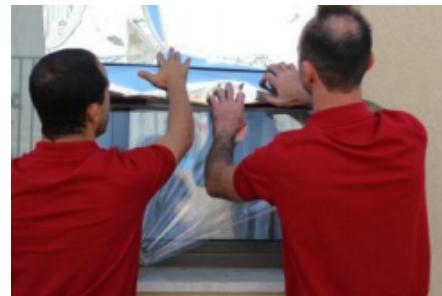
**Paso 7 alternativo** - Separe el soporte del film precortado (enrollado con el soporte hacia afuera) y rocíe la capa adhesiva con una cantidad generosa de solución humectante. Asegúrese de mojar la ventana con mucha solución humectante.
