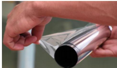
**Paso 3 - Precortado del film:** Precorte el film al tamaño de la ventana, dejando un solapamiento de 2 cm por todo el contorno: prepare el film directamente de la caja, cortando desde el lado duro con una cuchilla OLFA®. Asegúrese de que el film esté enrollado con el soporte hacia afuera (y el revestimiento SR hacia dentro).
