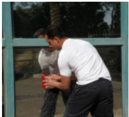
**Paso 7** - Retire el soporte del film y rocíe la capa adhesiva expuesta con una gran cantidad de solución humectante.
