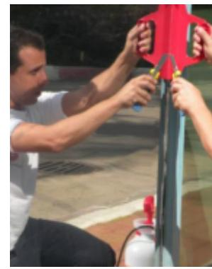
**Paso 9** - Deslice una espátula rígida de 6" desde el centro con movimientos firmes hacia abajo y hacia fuera, para eliminar las burbujas de aire y agua que hayan quedado entre el film y el cristal.
