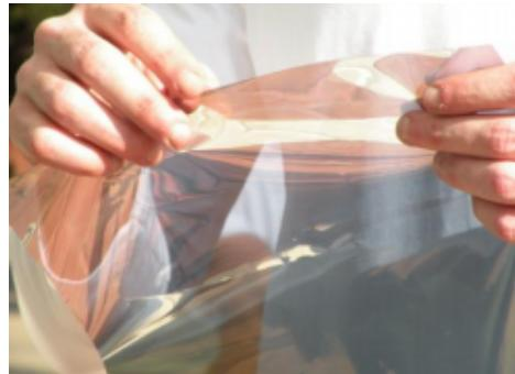
**Paso 6 c - Asgúrese de que EL FILM NO SE DOBLE HACIA EL LADO DEL SOPORTE,** para evitar que se agriete
