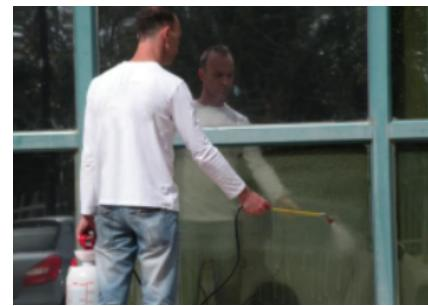
**Paso 4 - Rocíe el film:** Rocíe el film por las dos caras para evitar la energía estática (reduce la suciedad durante la instalación) y alisa el film.
